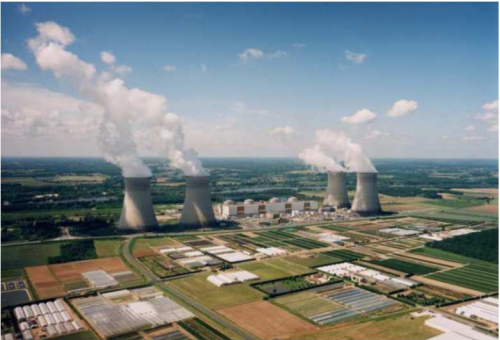
Figure 79 : Centrale nucléaire de Dampierre-en-Burly (Source : EDF)
