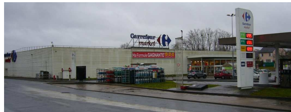
Figure 18 : Centre commercial sur le site de la ZACOM du Vieux Canal à Briare
